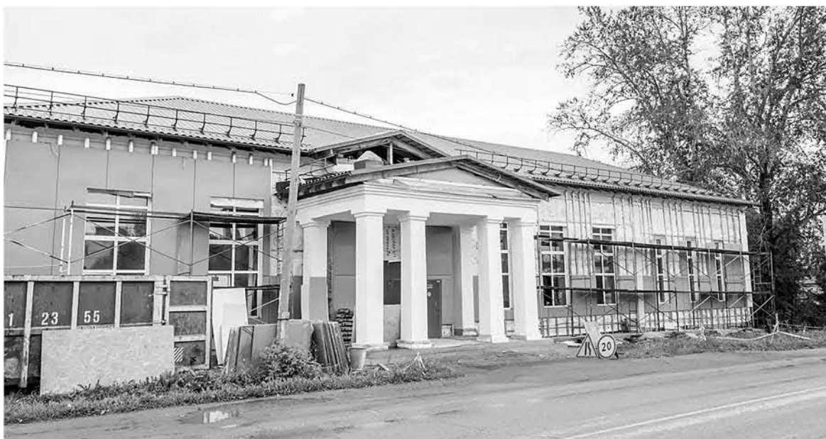
Один из этапов масштабной реконструкции Дома культуры в п.Юго-Камский — ремонт фасада здания
